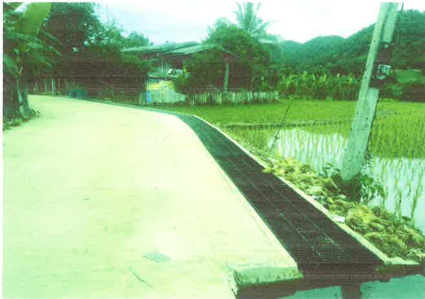
ภาพถ่าย โครงการก่อสร้างรางระบายน้ำพร้อมฝาดปิด บ้านไผ่แพะ หมู่ที่ ๕ (เหมืองหลวง) ตำบลเมืองมาย อำเภอแจ้ห่ม จังหวัดลำปาง (จ่ายขาดเงินสะสม ๓๓๕,๐๐๐ บาท)
